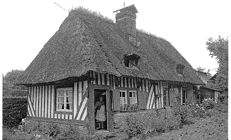
屋根に乗った芝にも表情があって、 ガーデニングの一部のように似合っています。
