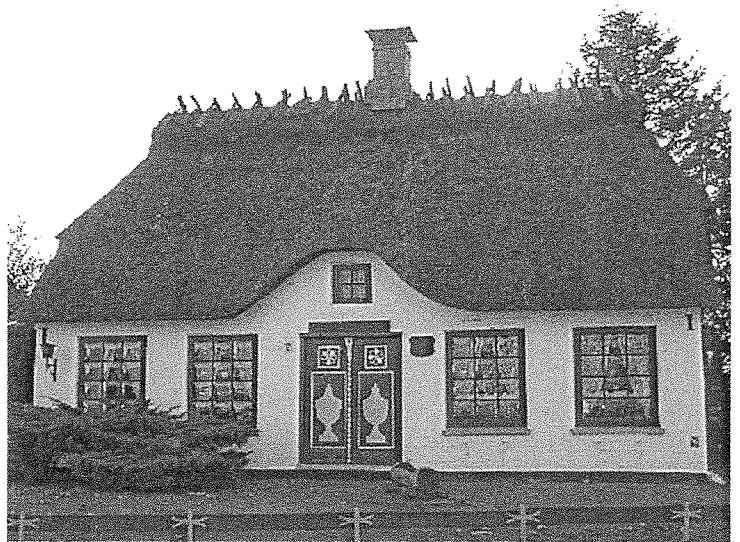
アシ葺き屋根の上の棟飾りは、棟を固定する役割もあります。
